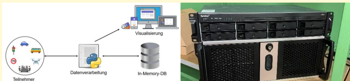
Abbildung 6: Das linke Schaubild zeigt das grobe Aufbaukonzept des EM von der Dateneinspeisung bis hin zum Monitoring und temporären Speicherung anonymer Daten. Das rechte Foto zeigt den geplanten Server mit Festplattenanbindung im BBW-Serverraum
