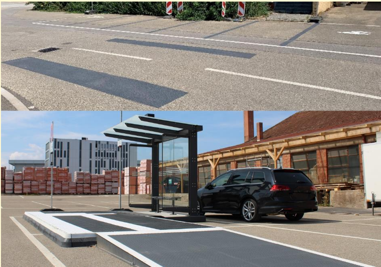
Abbildung 2: Beispiel der geänderten Markierung hier: der Überweg vom Bahnhof Waiblingen zur Bushaltestelle, die barrierefreie Bushaltestelle mit Wartehäuschen und Haltestellenschild. Firma Zicla, Vectorial Stecksystem für die Plattform & Firma Kienzler Stadtmobiliar GmbH, K13 Planum als Wartehalle
